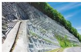
アンカー法面
