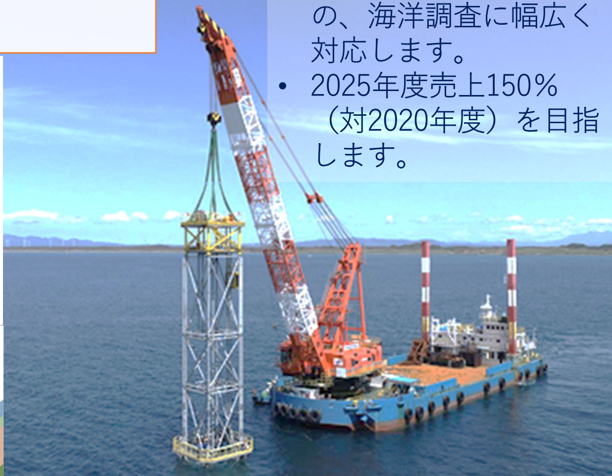
海上ボーリング調査のための50m級大型櫓の設置
