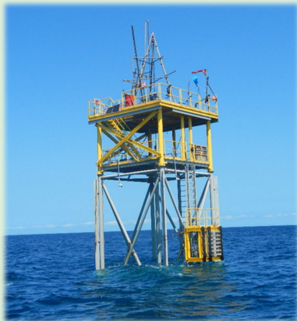
海上のボーリング調査
