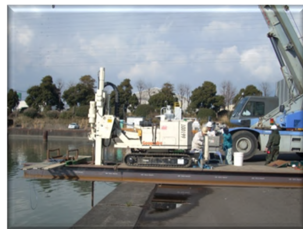
・ 張出し足場での事例
