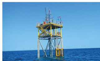
海上ボーリング
