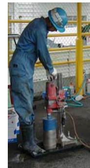
◎ダイオキシン類対象の試料採取 コア抜き (表層に覆工がある場合)
