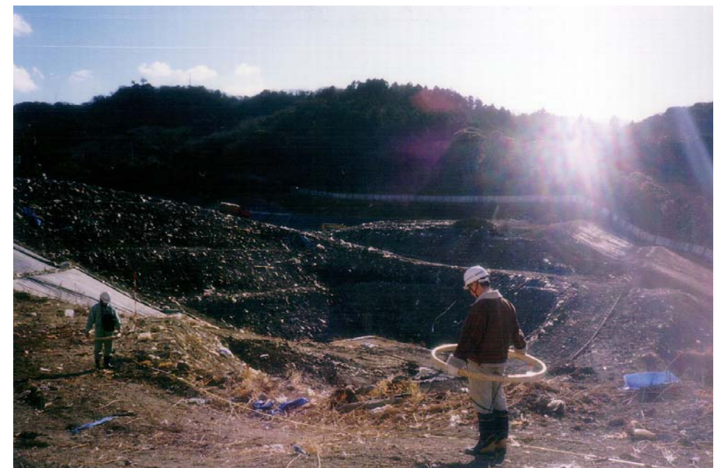
産業廃棄物処分場で実施中のEM探査法
