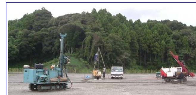
埋立地盤の層厚確認調査
