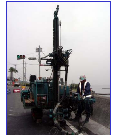
道路の空洞確認調査
