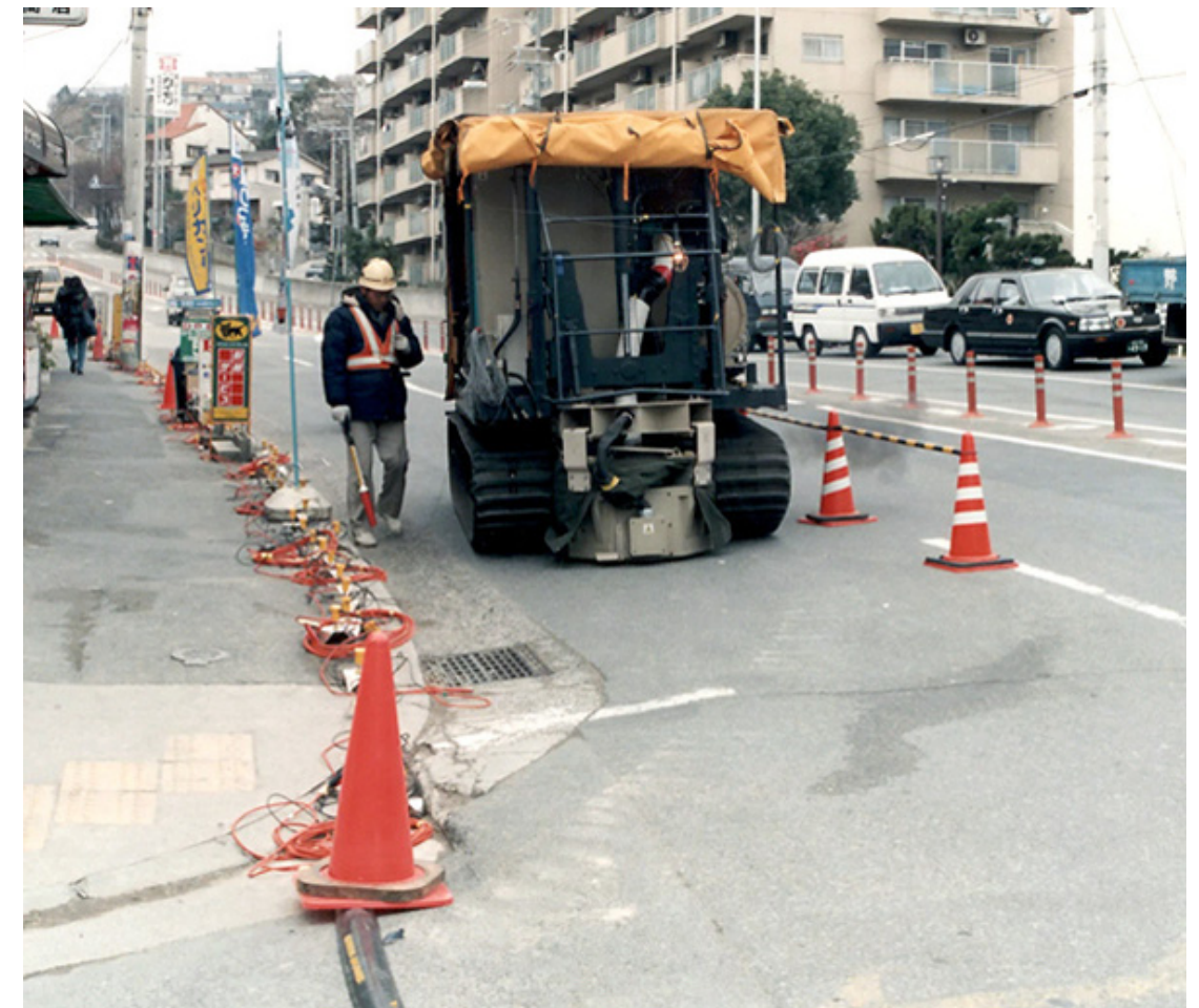
反射法地震探査の実施状況(神戸市)
