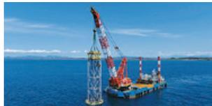
三国屋建設株式会社との共同で開発した日本初の水深50mに対応可能な大型檣のえい航状況。これまでの鋼製檣では水深35mが最大水深であったが、この大型檣開発により洋上風力発電事業における対応の幅が増加しました。
