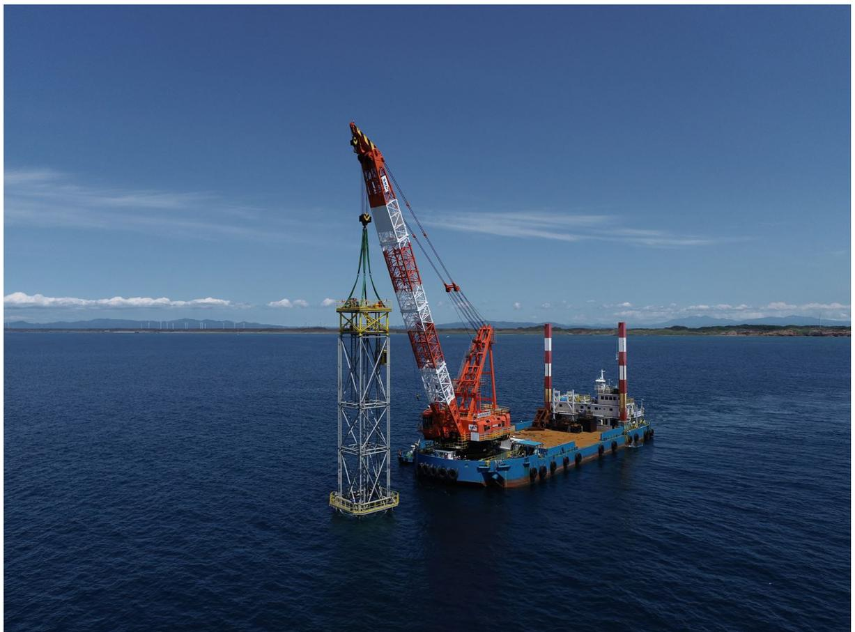
写真1 設置中の大型鋼製櫓
